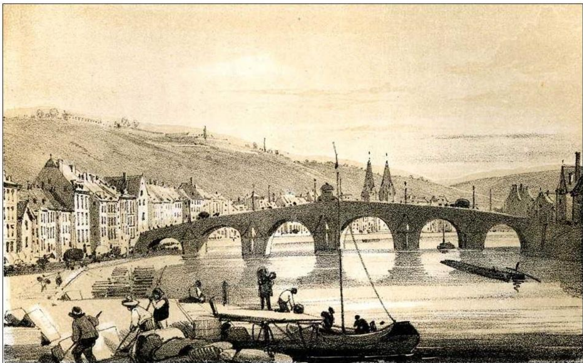
LE PONT DES ARCHES, À LIÈGE.
